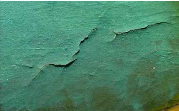
▲ 顔料層の剥離
